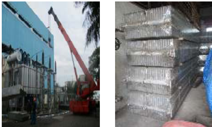
Gambar 4.4 Perbaikan Radiator Transformator 150 KV ST 2.0 Sumber dokumentasi penulis
