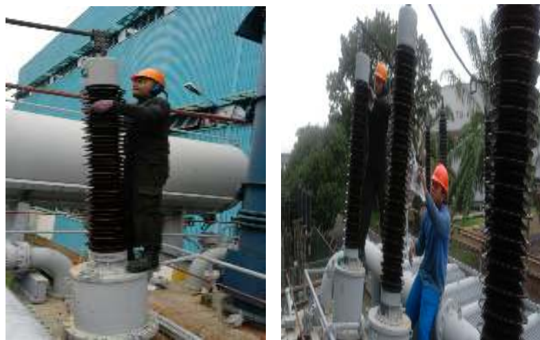
Gambar 4.3 Pembersihan Bushing Transformator 150 KV ST 2.0 Sumber dokumentasi penulis
